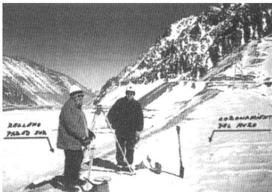
Foto 1. Mediciones sobre el muro de embalse; se puede apreciar el monolito o punto de control y el relleno de la pared sur del muro
