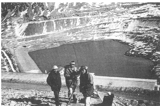
Foto 3. Panorámica del muro del embalse desde el P. R. CMDH, en época de primavera
