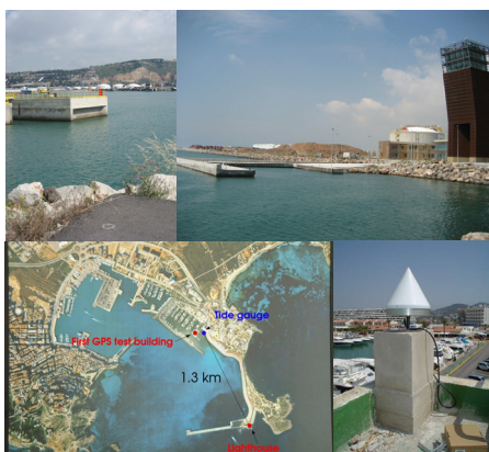
Figura 1.- Infraestructura CGPS en el Puerto de Barcelona (imagen superior) y del Puerto de Ibiza (imagen inferior).
